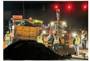
Las rupturas de tuberías principales de agua son graves y reciben nuestra atención inmediata. Cuando ocurren, los equipos responden de manera segura y rápida para reparar y restaurar el servicio de agua. Dependiendo del tipo de ruptura, se puede cortar el agua. La RWA hace todo lo posible para notificar a los residentes antes de que esto suceda. Reparar la ruptura de una tubería principal de agua generalmente demora de cuatro a seis horas.
